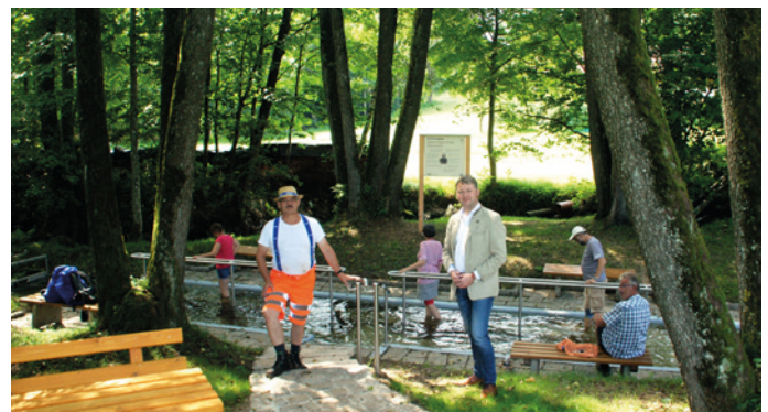
Erneuerung der Wassertretanlage
