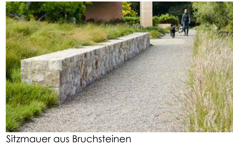
Sitzmauer aus Bruchsteinen
